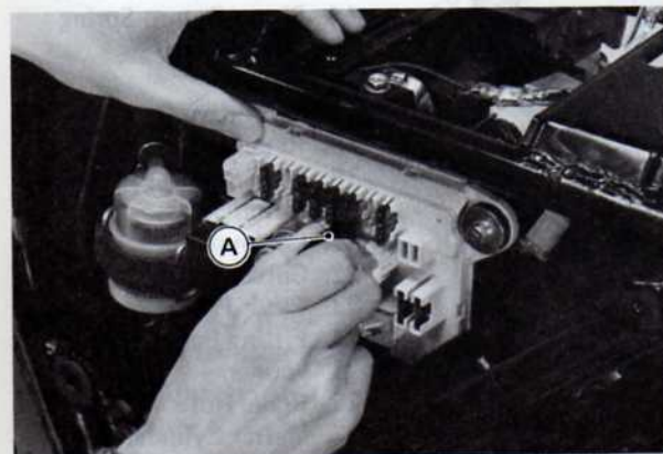
A. Remove fuses using puller.
